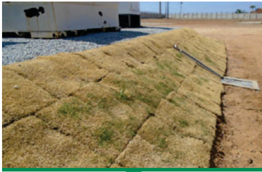
Exemplo de medida do PRAD: plantio de gramínea e implantação de drenagem pluvial no talude
