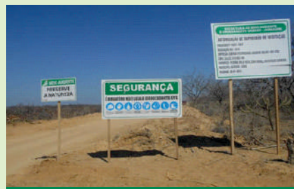
Exemplo de medida do PAC: Controle de sinalização de obra
