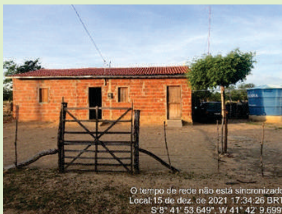
Casa existente nas proximidades da área do Parque Solar
