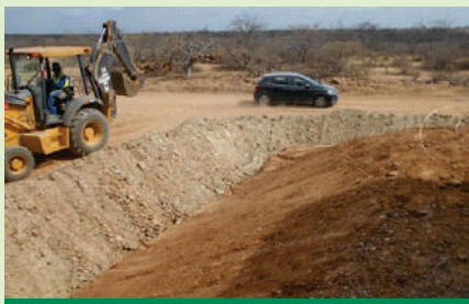
Exemplo de medida do PAC: Controle Erosão e Assoreamento – implantação do sistema de drenagem, para realizar a coleta e o direcionamento das águas
